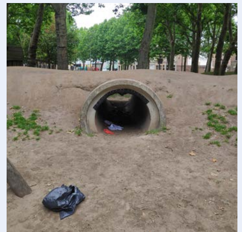
De tunnelelementen en het houten huisje vormen beschutte plekken waar ook daklozen gebruik van maken. Met als gevolg dat de plek er wat verwaarloosd uitziet.
